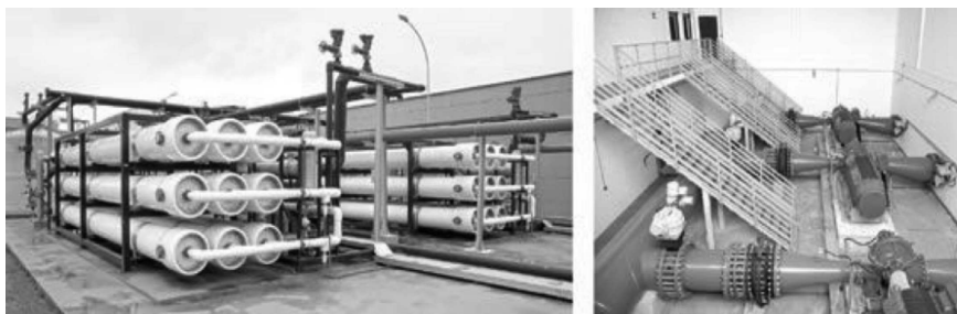
Figura 9 - Osmose reversa- Aquapolo
