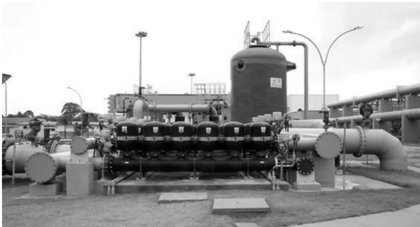
Figura 6 - Filtro de discos- Aquapolo
