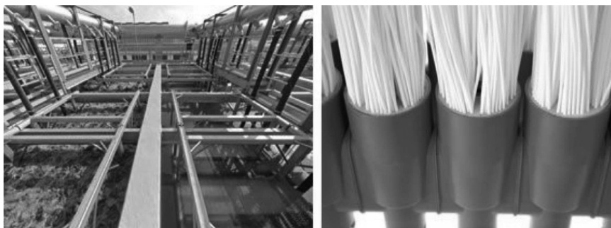
Figura 8 - Membranas TMBR- Aquapolo
