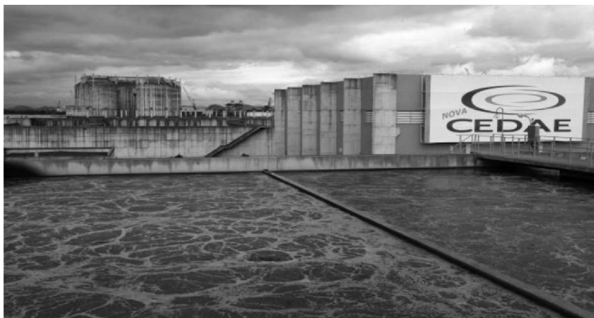
Figura 4 - Tanque de aeração - CEDAE.
